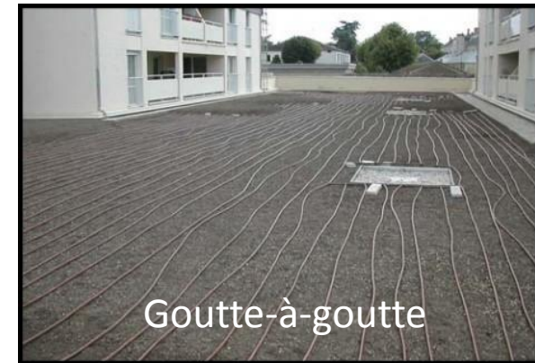
Végétation en toiture
